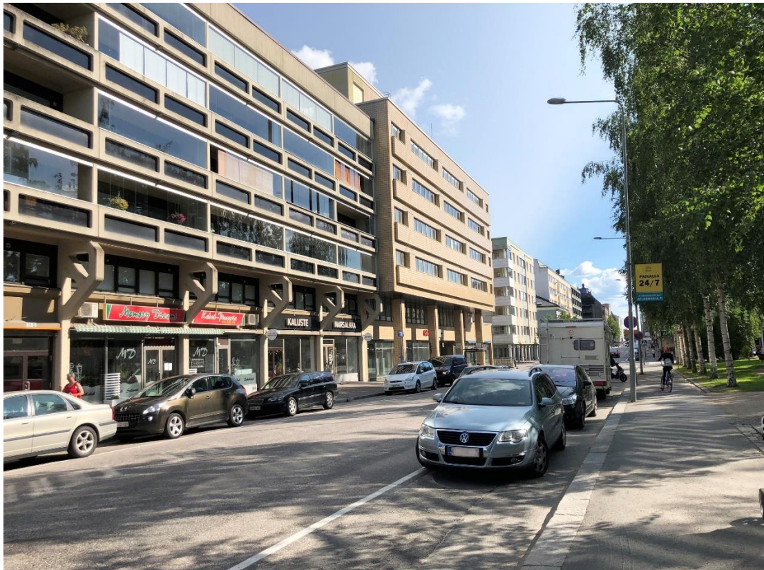
Kuva 6 Porrassalmenkatu 29 liike- ja toimistorakennus on osa yhtenäistä Porrassalmenkadun katujulkisivua. Korttelissa 1 rakennusten ensimmäiset kerrokset ovat sisäänvedetyt, ja katutilaan muodostuu arkadikäytävä. Porrassalmenkatu 29 julkisivu työntyy naapurirakennuksia enemmän katutilaan ja muodostaa ulokkeen.
