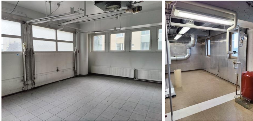
Kuva 30. Tila nimeltä tarkastusasema kellarissa K1. Nosto-ovet aukeavat rakennuksen itäpuoliselle pysäköintialueelle. Kuva 31. (oik.) Seitsemännän kerroksen iv-konehuonetta.
